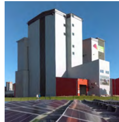
Site Sud-Ouest Aliment de Saint-Sylvestre-sur-Lot (47) avec panneaux photovoltaïques pour de l'autoconsommation.
